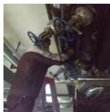
避免跑、冒、滴、漏等情况发生以免给业主家造成不必要损失。工程人员根据计划安排，将主管道滤网和业主分户滤网进行了清洗，并查看户内供暖设施完好情况。
